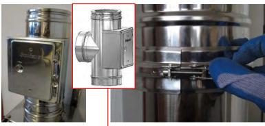
Montirajte priključak za reviziju. Obratite pažnju kod nekoih tipova ICS-a (EasyMont) priključak za < reviziju i peć nalaze se na istom elementu.
