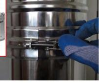
Spajanje elemenata vrši se na jednostavan način pomoću obujmice. Na obujmici se nalazi šraf kojim podešavate potrebnu silu stezanja. Vodite računa da obujmica nalegne na žlebove i da bude dobro stegnuta.
