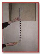
Pre početka montaže proveriti visinu priključka za ložišta. Visina se određuje osno u odnosu na cev priiključka.
